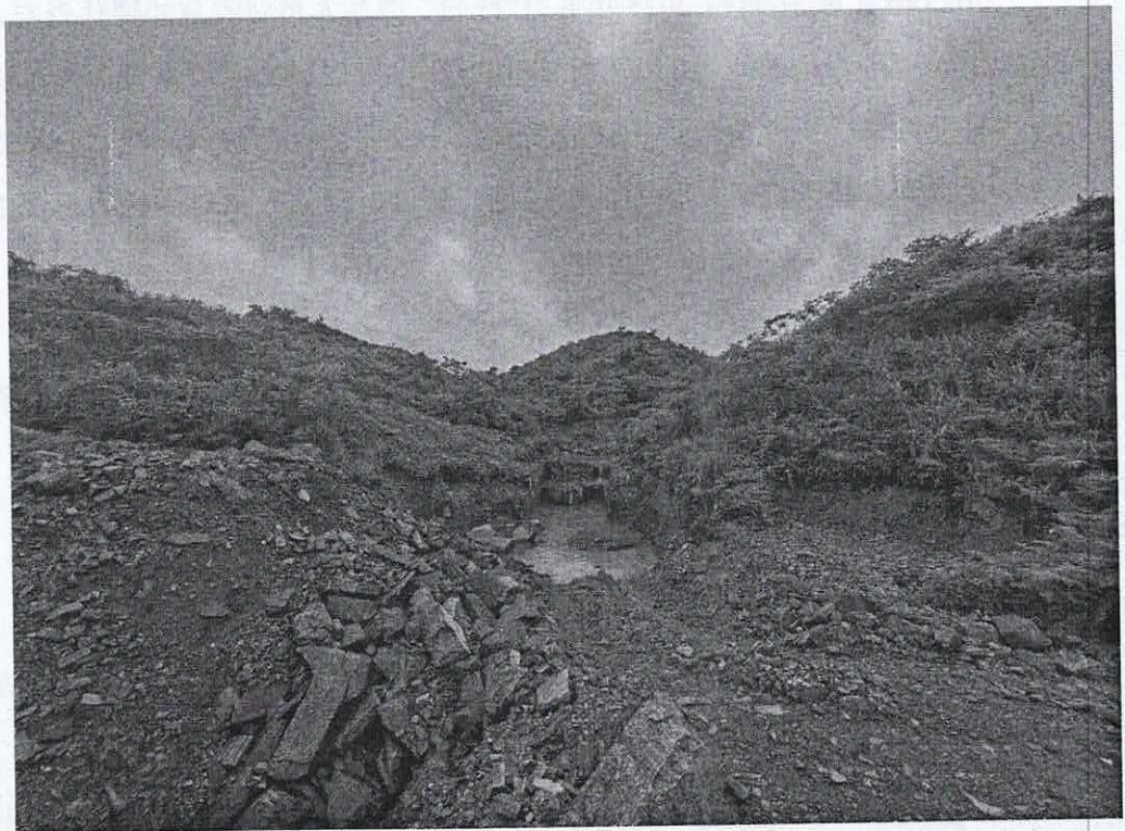
现场调查照片 2
